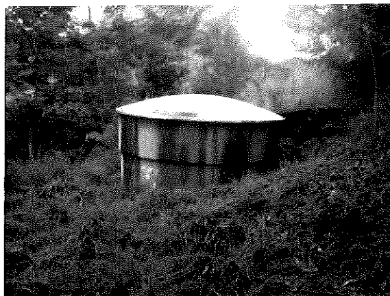
FIGURA 29 – RESERVATÓRIO – DISTRITO DE BONSUCESSO (FONTE: ACERVO DO AUTOR, 2014)
